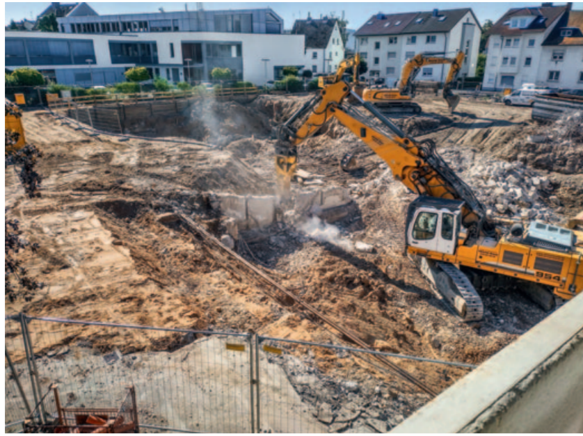
Bei den Rückbauarbeiten stießen wir wortwörtlich auf die Fundamente des Unternehmens
