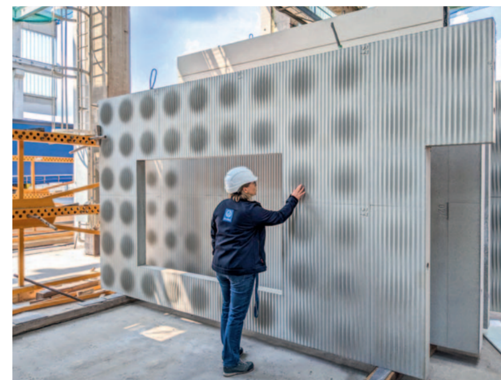
Qualitätskontrolle: Die Betonfertigteile mit der Wellenstruktur stammen aus unserem Werk in Stockstadt
