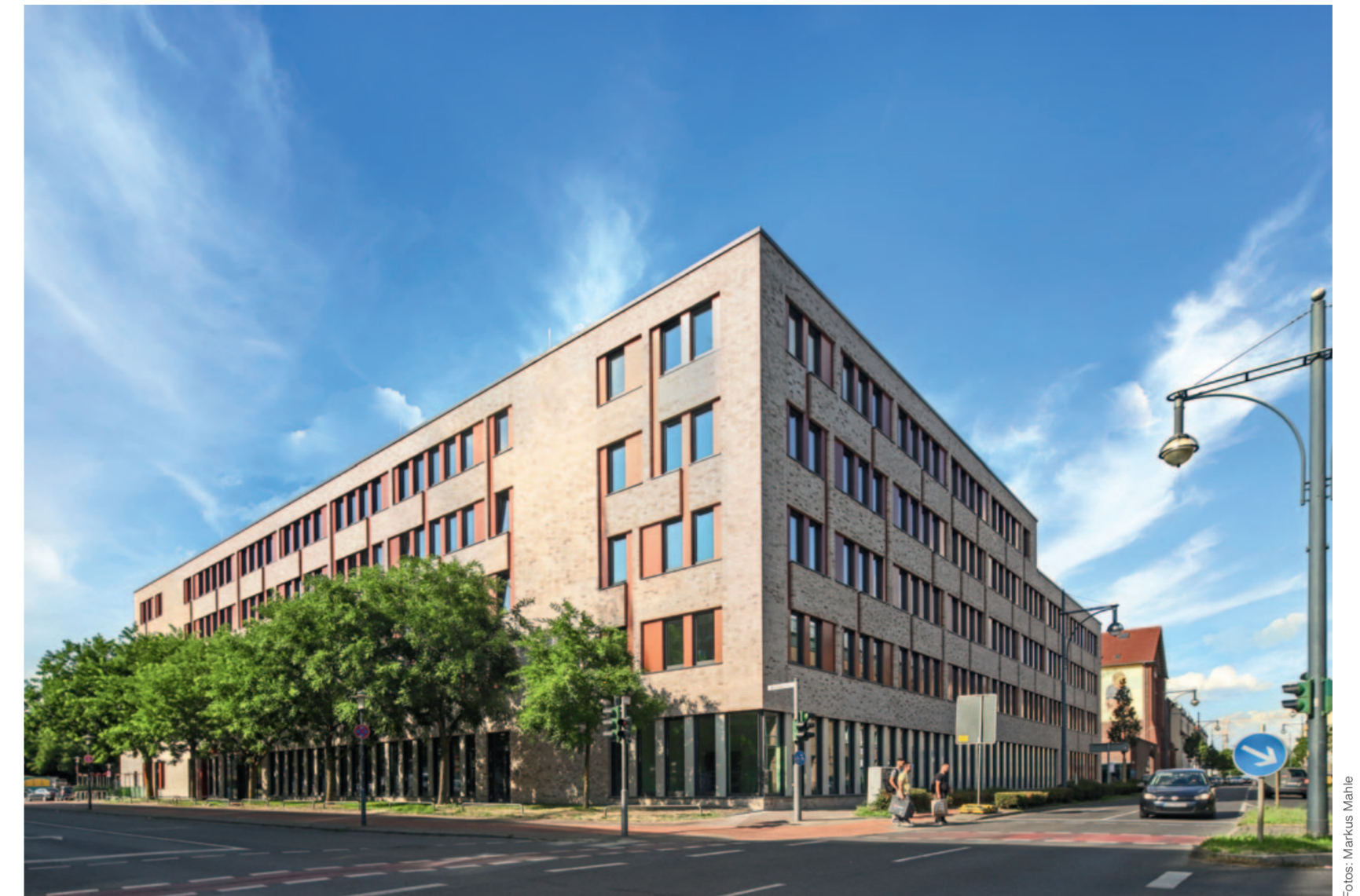
Inzwischen profitieren die Mitarbeitenden von der wohlthuenden neuen Arbeitsumgebung. Bereits im Juni stellte Dreßler Bau das Gebäude fertig, der Bezug war Anfang August.
