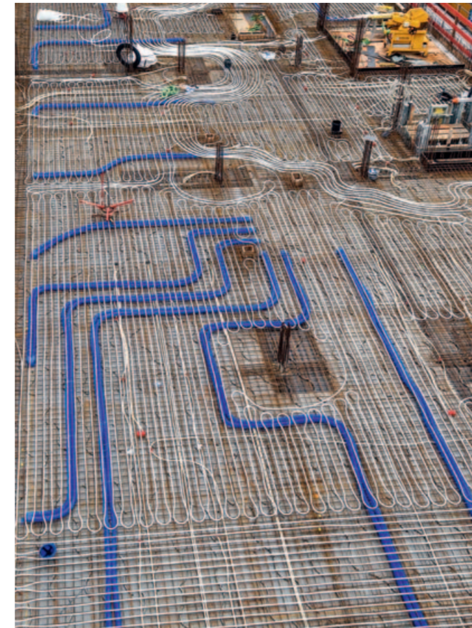
Dieser Einblick in die Bauphase zeigt anschaulich die verschiedenen Komponenten, die in die Betondecke integriert werden mussten. Die blauen Röhre dienen zur Vorhaltung der Belüftung. Weiß schlingelt sich die flächige Baukerntemperierung durch den Beton. Die weißen geraden Leerrohre sind für die Elektroinstallationen vorgesehen.
