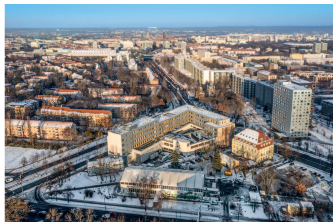
Ein weiteres architektonisches Puzzlestück vervollständigt die Barockstadt Dresden. Der moderne Hybridbau in der Südstadt ist ein Gewinn für die Umgebung und die Studierenden.
