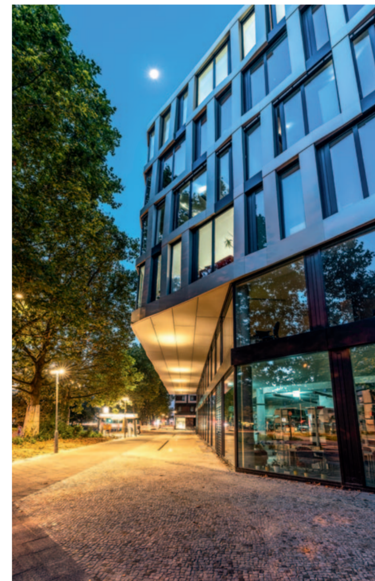
Die außergewöhnliche freie Auskragung von 5 Metern – auf einer Gesamtlänge von 35 Metern und in einer Höhe von 8 Metern – erforderte spezielle Maßnahmen und besonderes Know-how
