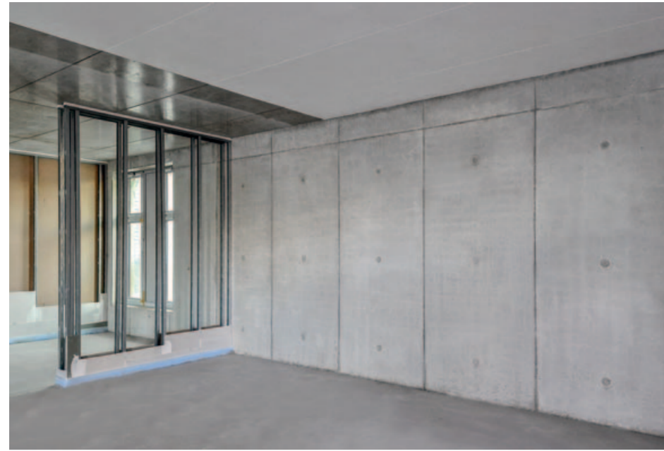
Eine der größten Herausforderungen war die Umsetzung der Anforderungen an den Sichtbeton in Kombination mit der hohen TGA-Dichte in den Betondecken und -wänden
